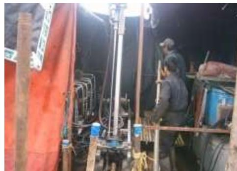
**Foto 6.12. Perforación de sondajes exploratorios (Foto de archivo)**
